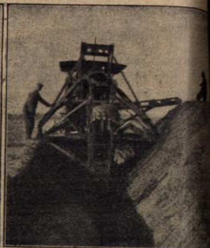
Vom westlichen Kriegsschauplatz: Kanadischer Riesendampfpflug zum Schnellausheben von Schützengräben. (Nach englischer D.
