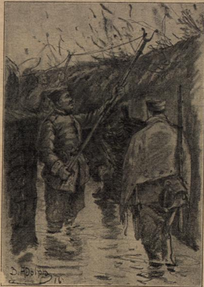
Erschwerte Arbeiten unserer Feldgrauen in einem durch Regen beschädigten Zulaufgraben.
