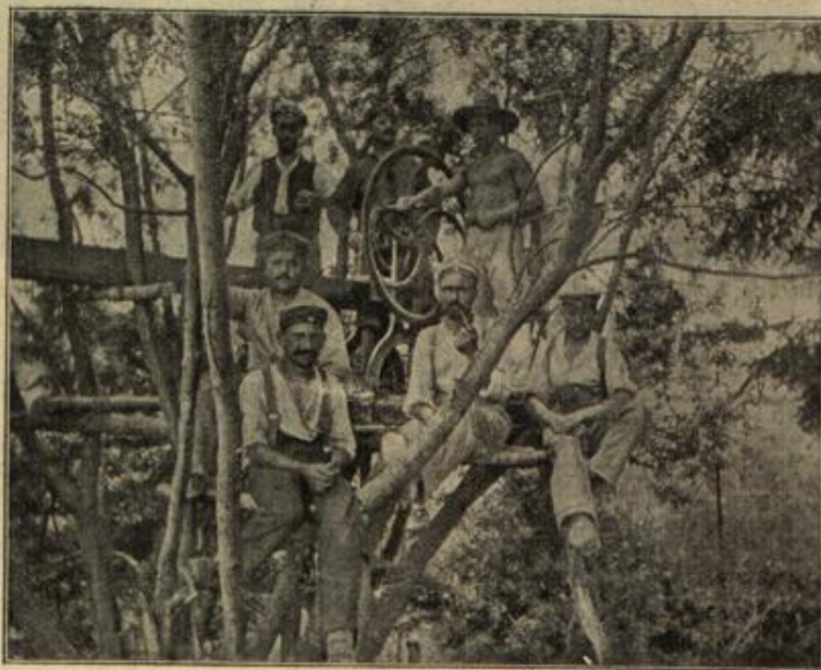
Pumpvorrichtung zum Entwässern und Trodenhalten von Schützengraben.
