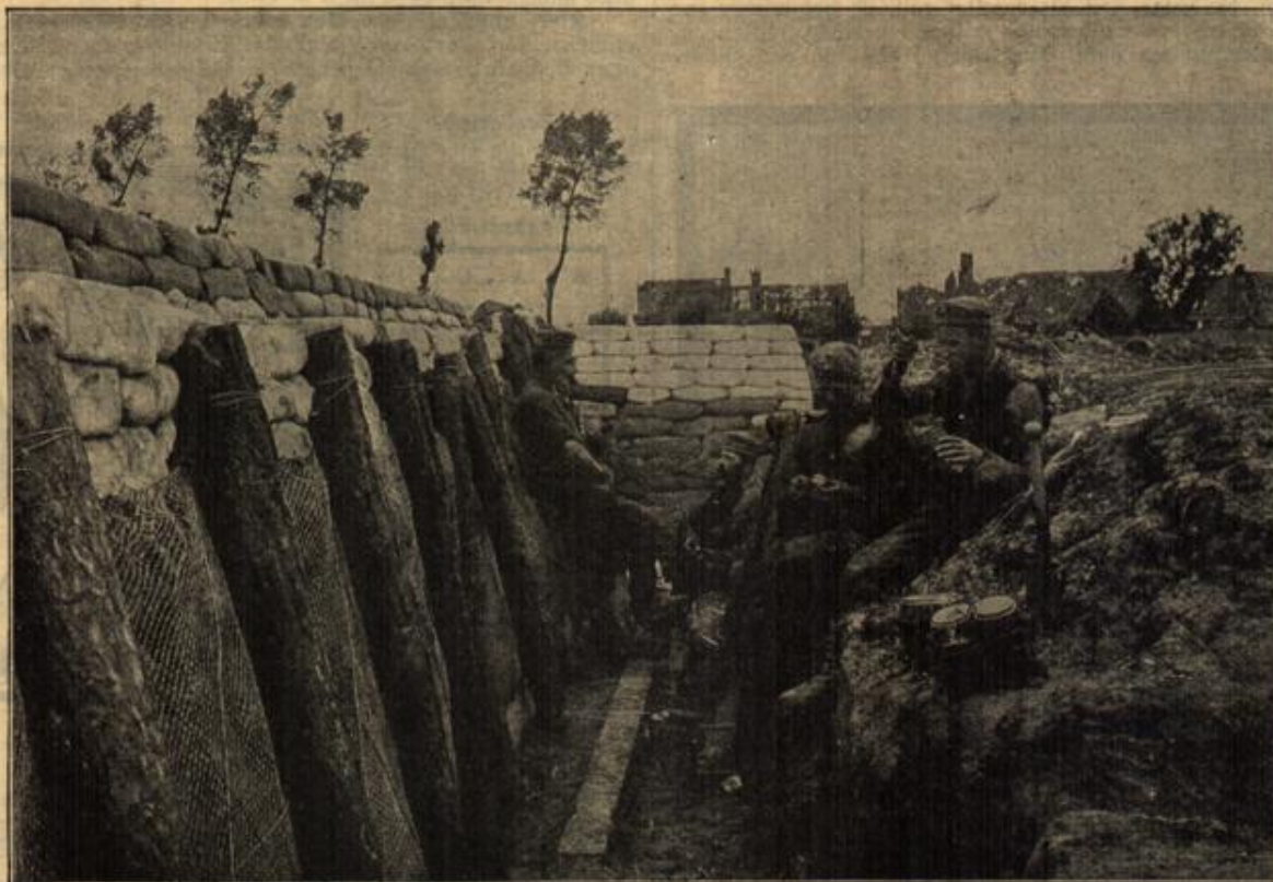
Aus Flandern: Im Hinblick auf einen Winterfeldzug vorgesehener, verstärkter Ausbau von Schützengräben.
