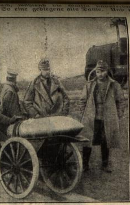
Geschözwagen der österr. 30,5 cm-Motormörser mit einem Geschö. (Mit Text.)
