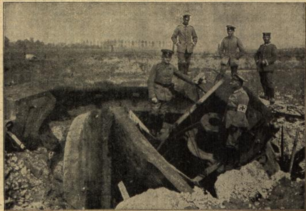
Zerschossener Panzerturm des Forts Loncin bei Lüttich.
