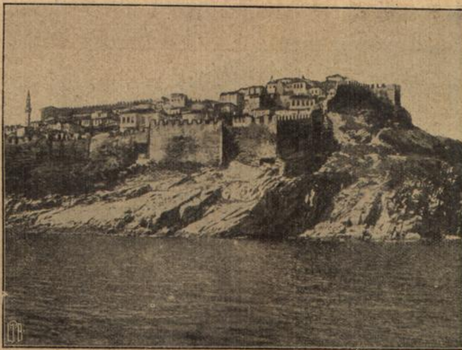
Die griechische Hafenstadt Cavala wurde von den Bulgaren besetzt.
