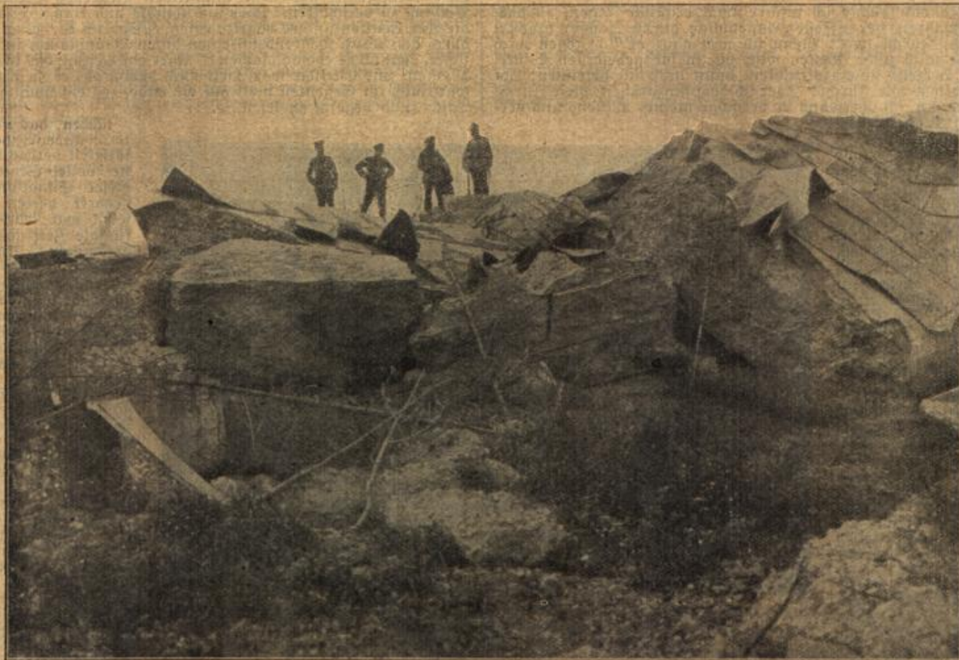
Zerspaltene Eisenbetonblöcke am Fort 11 von Przemysl, die die furchtbare Wirkung unserer schweren Artillerie zeigen.
