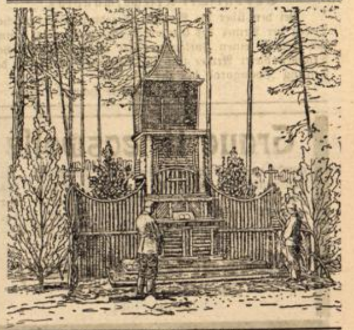
Waldkapelle in Russisch-Polen, eine aus Baumstämmen und Zweigen verfertigte Arbeit unserer Feldgrauen.
