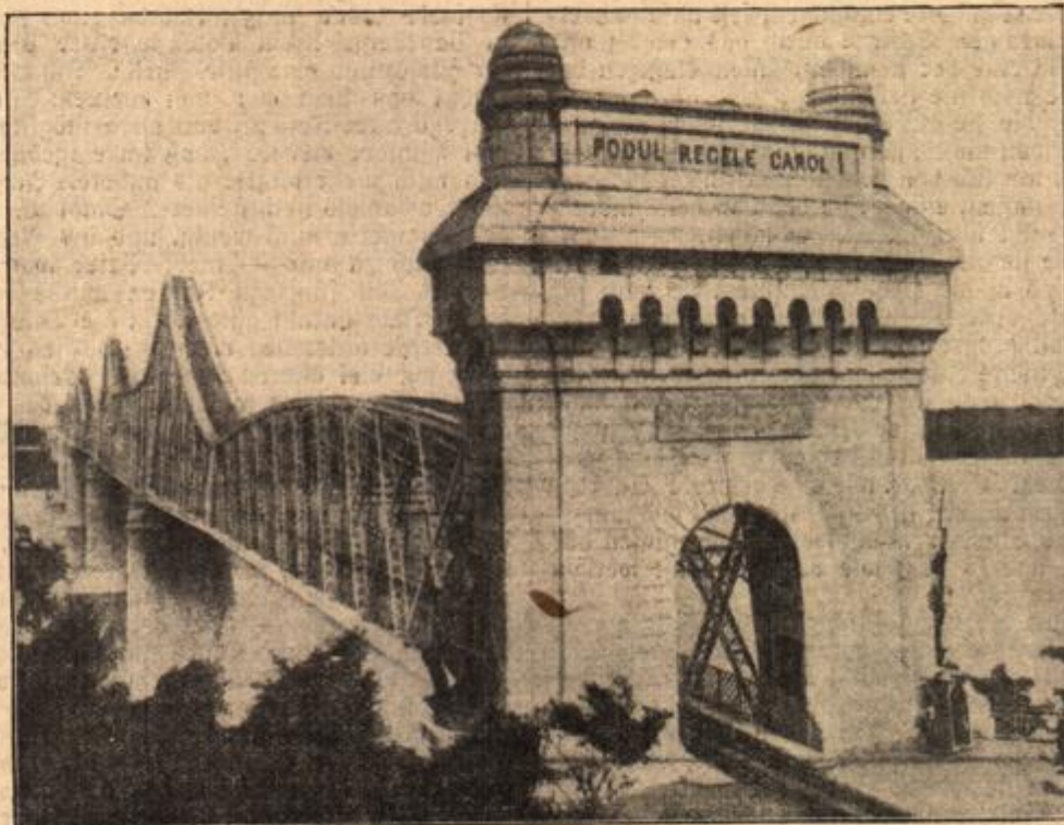
Die 750 Meter lange Donau-Brücke bei Cernavoda.
