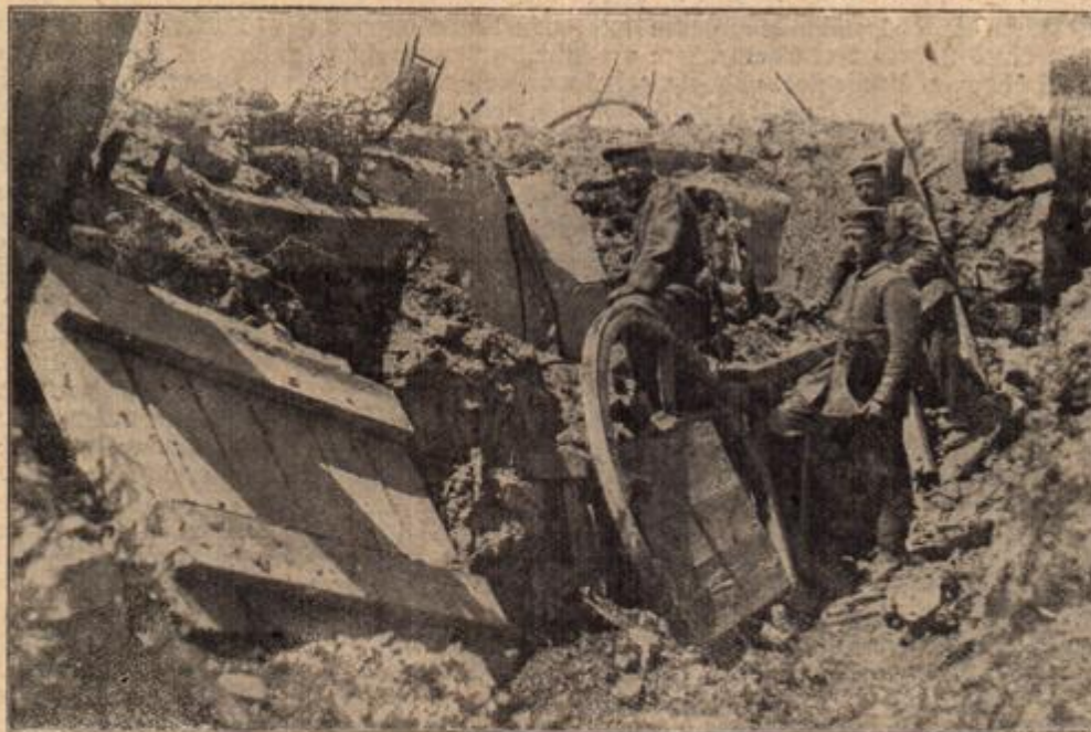
Zerschossene betonierte Truppenunterstände an der Somme. (Zensiert Gen.stab.)
