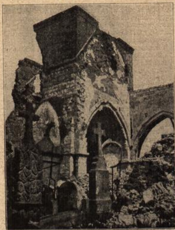
Überreste des Turmes der durch englische Granaten zerstörten Kirche in Porgies (franz. Flandern). Im Vordergrund ein Teil des um die Kirche belagerten Friedhofs, der ebenfalls gelitten hat.
