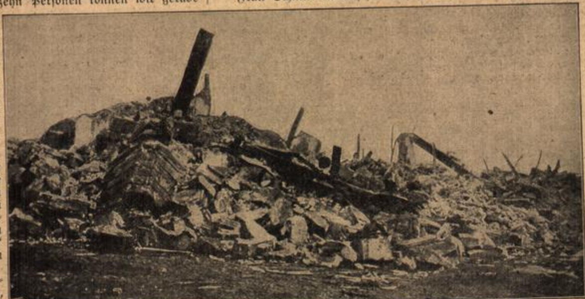
Die Reste einer starken franz. Verteidigungsstellung in dem von den Deutschen erströmten Werk Thiaumont.
