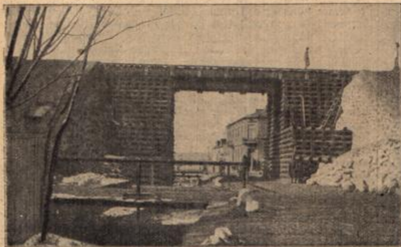
Notbrückenbau aus Bahnschwellen.
