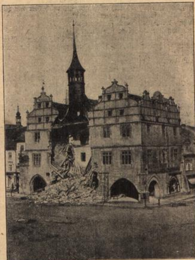
Der Einsturz des Leitmeritzer Rathhauses. (Mit Text.)
