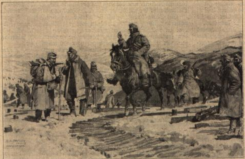
Herstellung von Ankippdämmen durch österreichisch-ungarische Arbeitsabteilungen.
