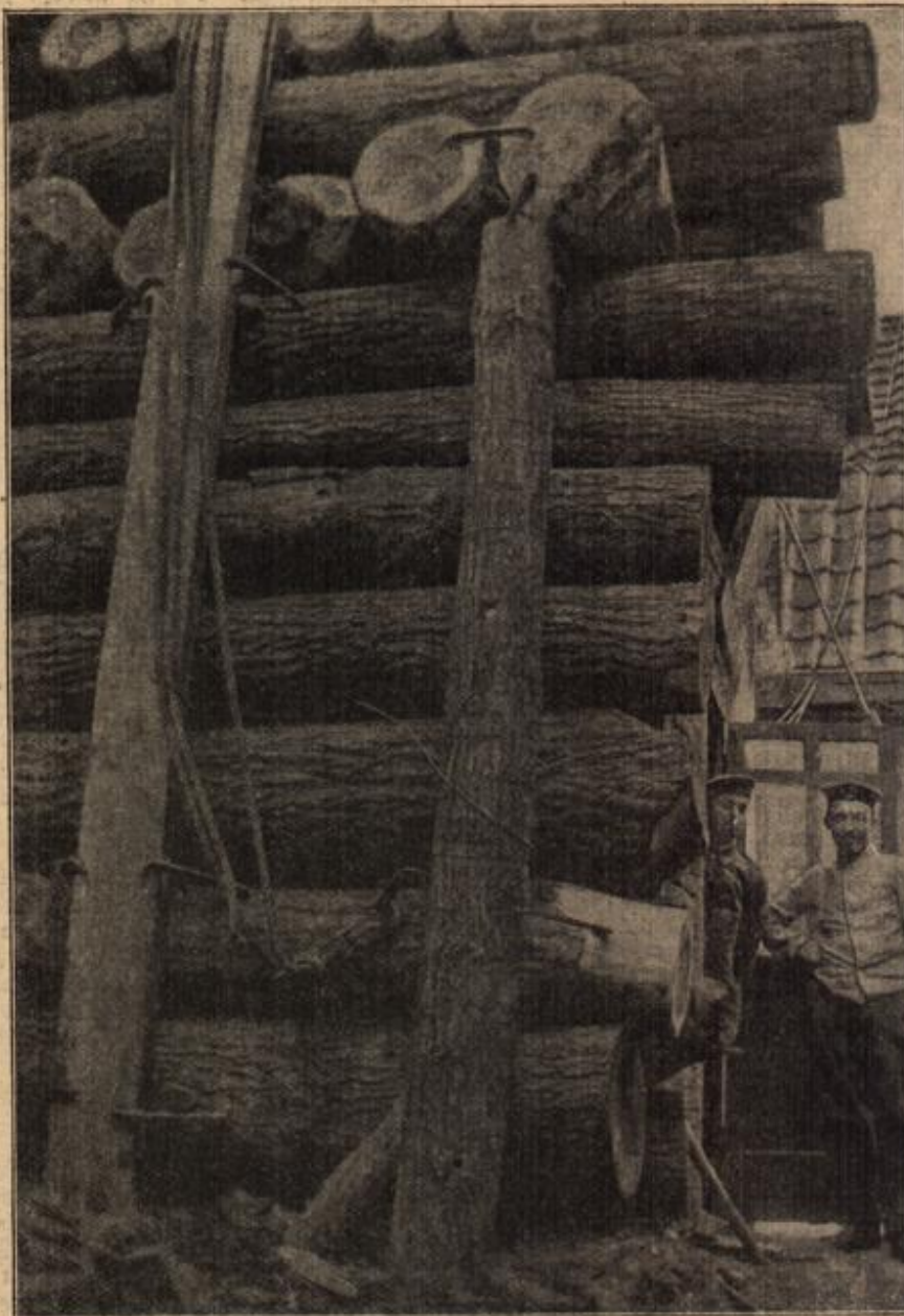
Sicherung eines Zernsprech-Unterstandes an der Aisne-Linie.
