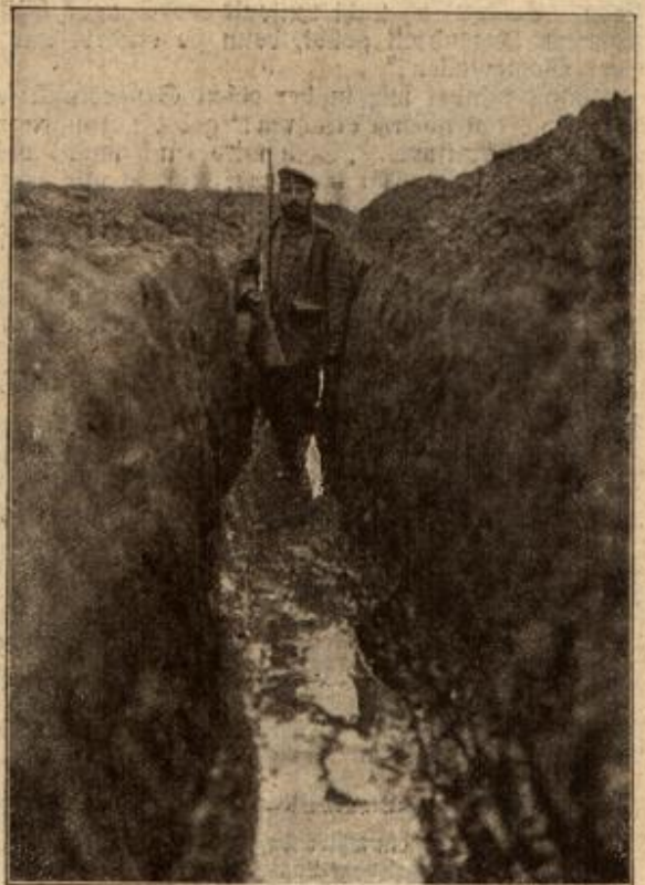
Verbindungsgraben zum Befördern von Munition und Nahrungsmitteln nach den vordersten Schützengräben.
