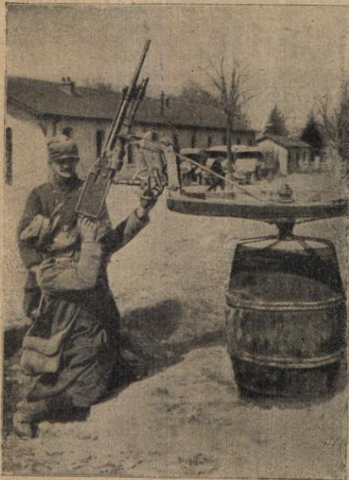
Französisches Maschinengewehr zur Abwehr von Flugzeugen auf einem Rad montiert, damit es in jede Richtung gedreht werden kann.
