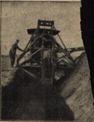
Vom westlichen Kriegsschauplatz: Canadischer Riefendampfpflug zum Schnellausheben von Schützengräben. (Nach englischer
