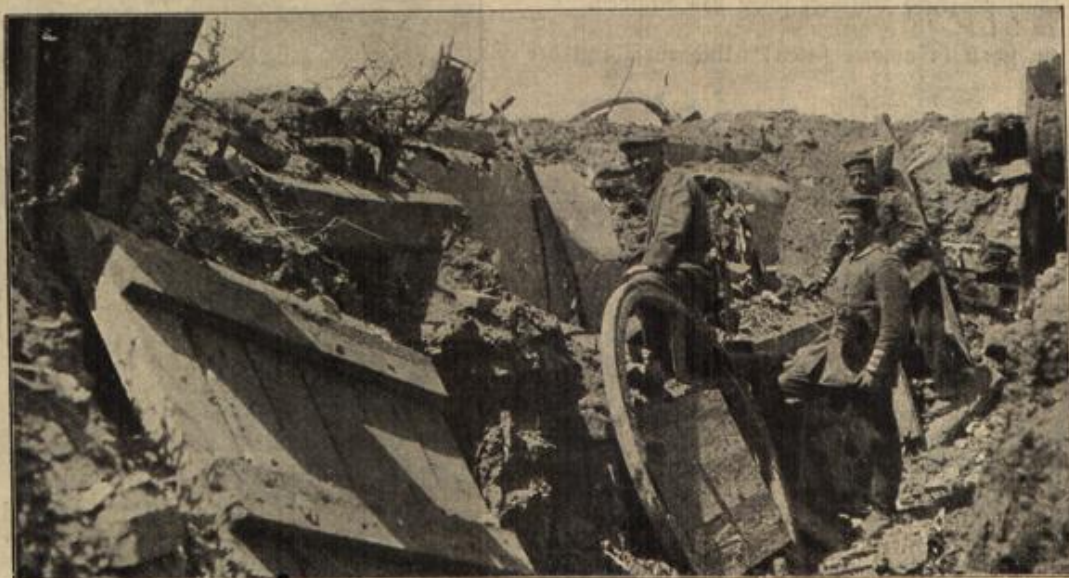
Zerschossene betonierte deutsche Unterstände an der Somme, die beim ersten Anprall verloren, dann aber zurückerobert wurden.
