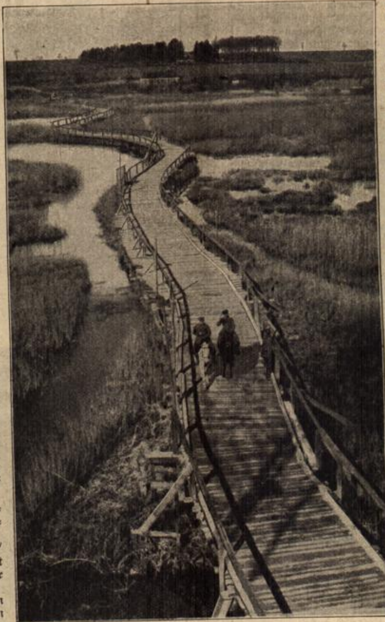
Die von deutschen Pionieren erbaute 450 Meter lange Kriegsbrücke bei Eterpigny in Nordfrankreich (S. 143).
