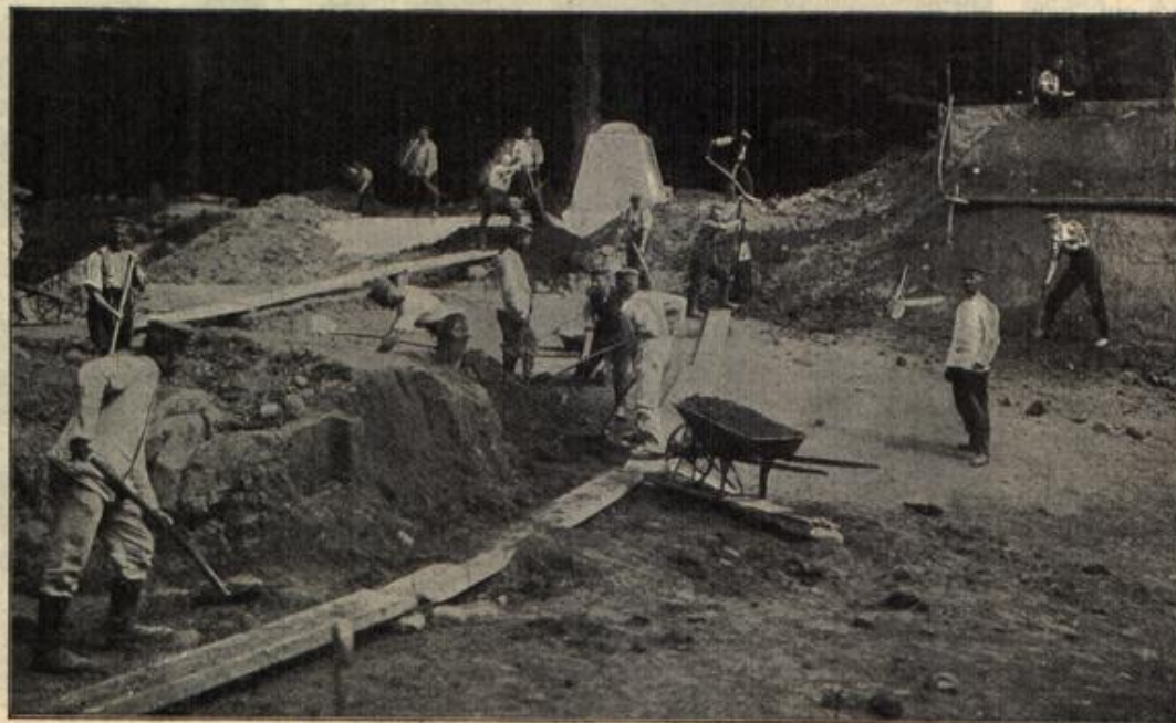
Deutsche Armierungssoldaten beim Bau einer Wasserleitung. (S. 143)
