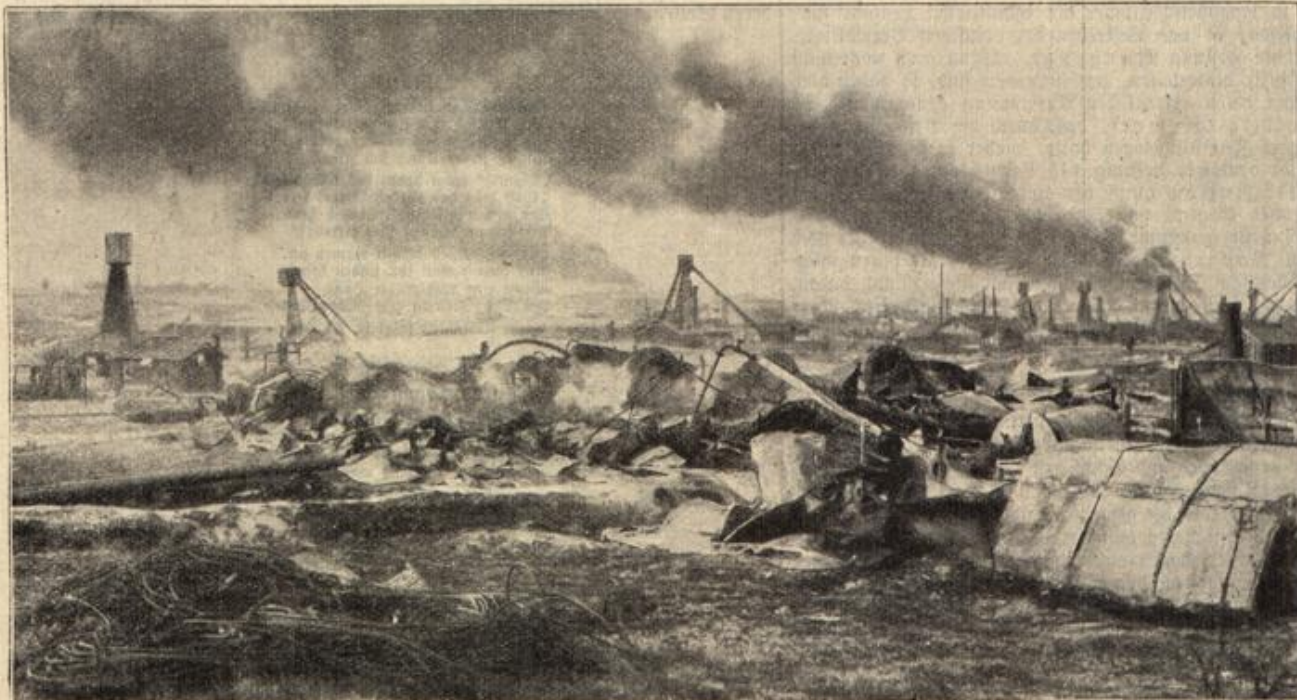
Die von den Russen in Brand gesteckten Naphtagruben Galiziens. (S. 120)
