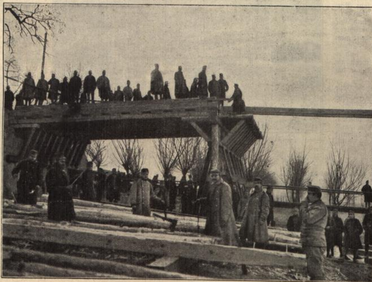
Österreichisch-ungarische Pioniere beim Brückenbau. (S. 68)
