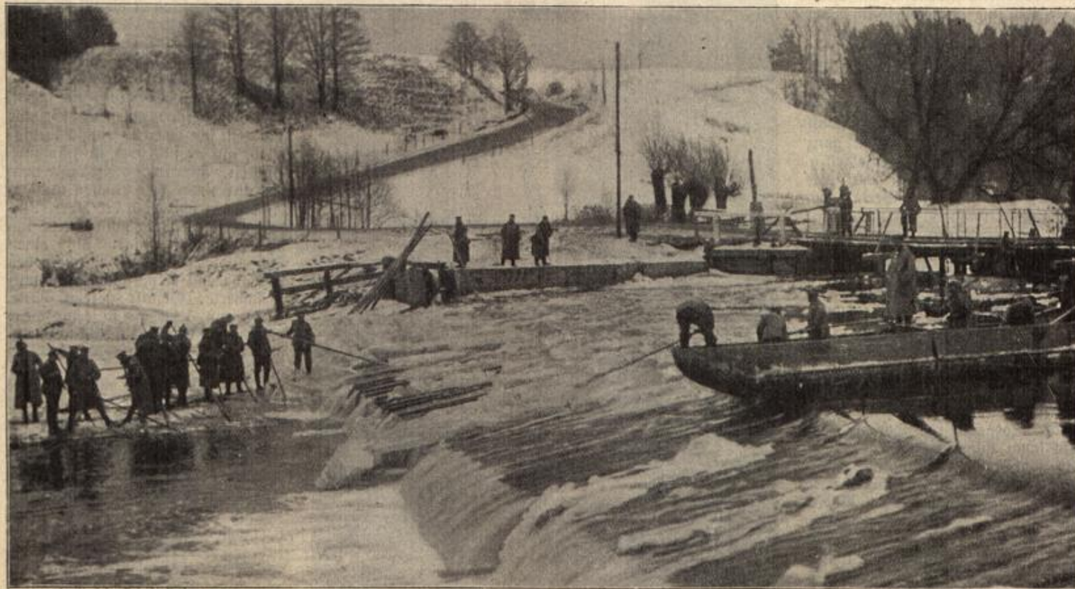
Eisbrecherarbeiten unserer Pioniere auf der Angerapp in Ostpreußen. (S. 16)
