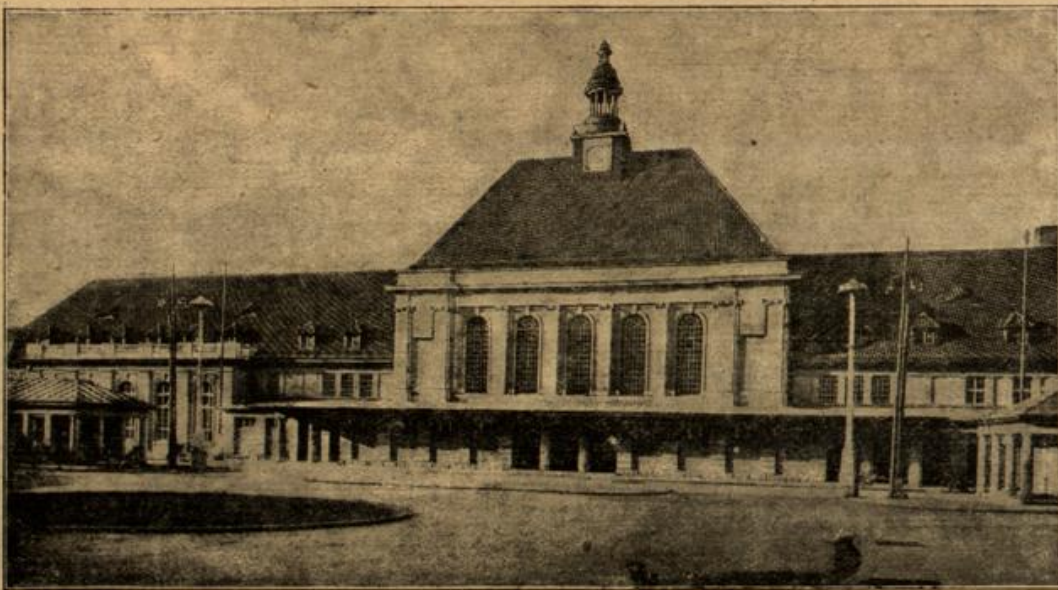
Der ſoeben fertiggeſtellte neue Bahnhof in Görlitz.
