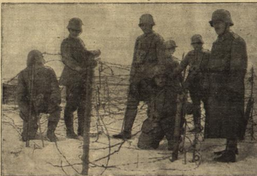
Pioniere beim Ausbessern eines Trahterverhaues im Felde.
