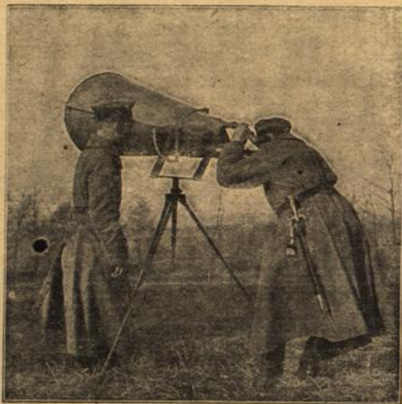
Spionhapparat, mit dem die Annäherungsrichtung feindlicher Flugzeuge festgestellt wird.
