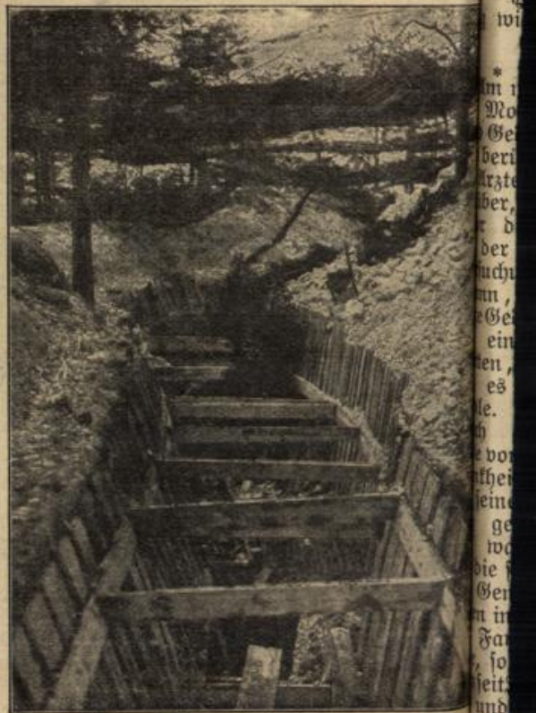
Bau eines 15 Meter tiefen Laufgrabens an der Westfront. (Mit Text.)
