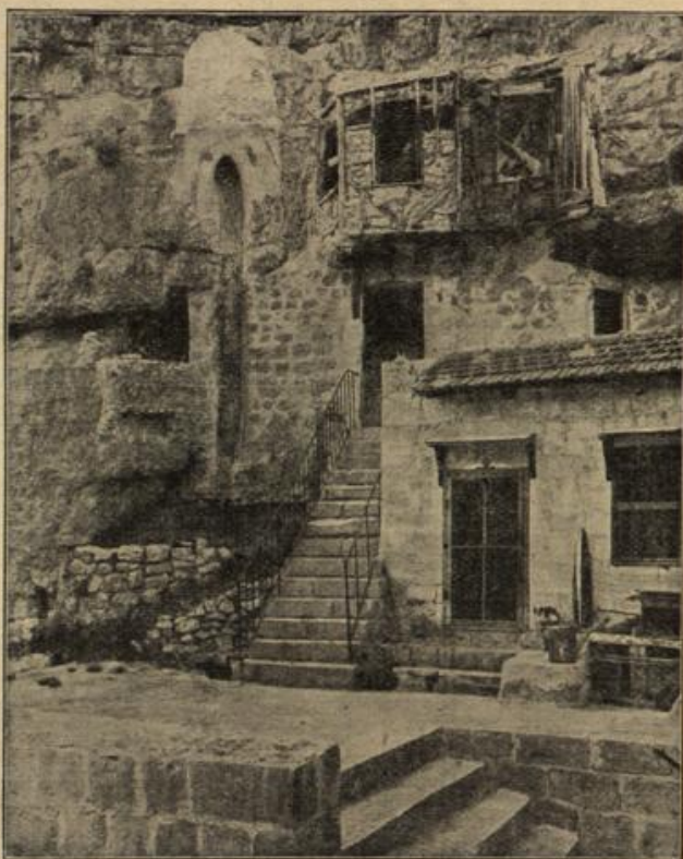
In die Felswände von Mar Zaba eingebaute Mönchswohnungen.
