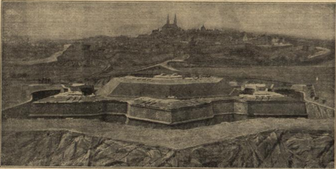
Die Befestigungswerke der Stadt Verdun.
