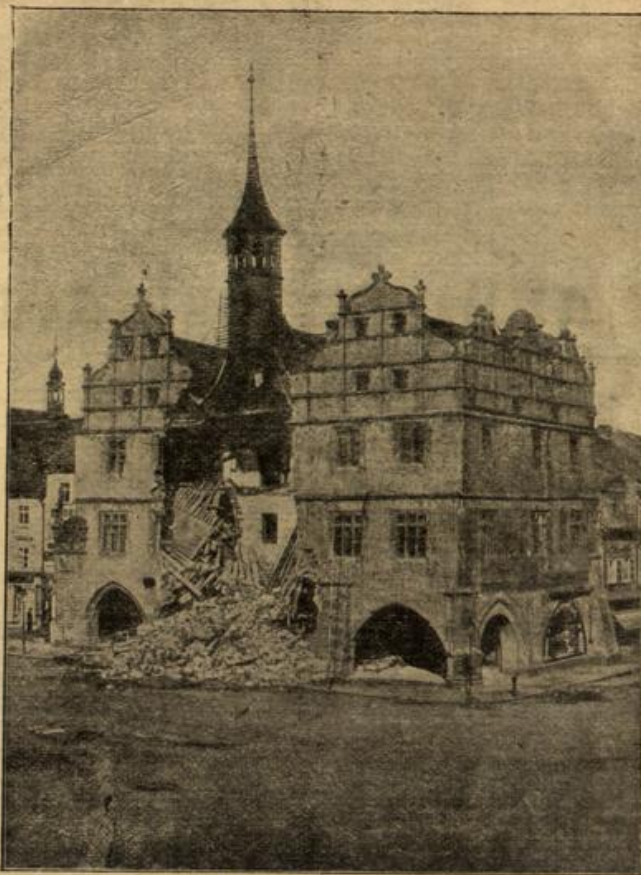
Der Einsturz des Leimer's Mühle. (Mit Text.)
