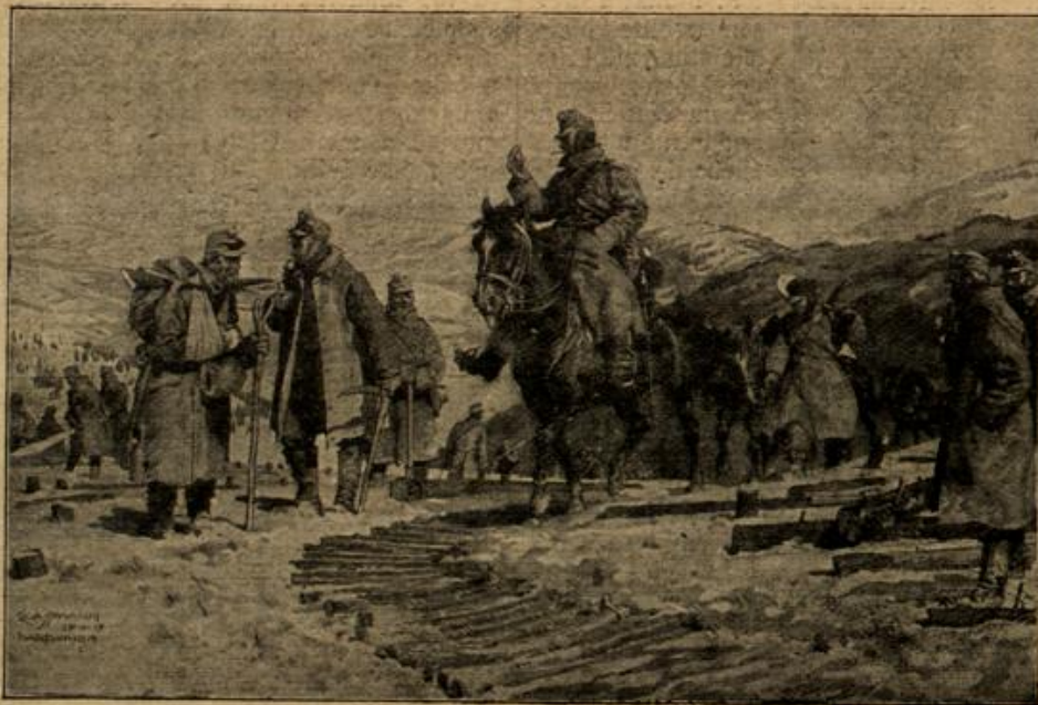
Herstellung von Knüppeldämmen durch österreichisch-ungarische Arbeitsabteilungen.
