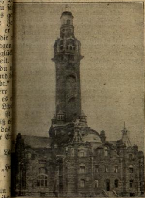
Das staatliche Fernheizwerk in Dresden. (Mit Text.)
