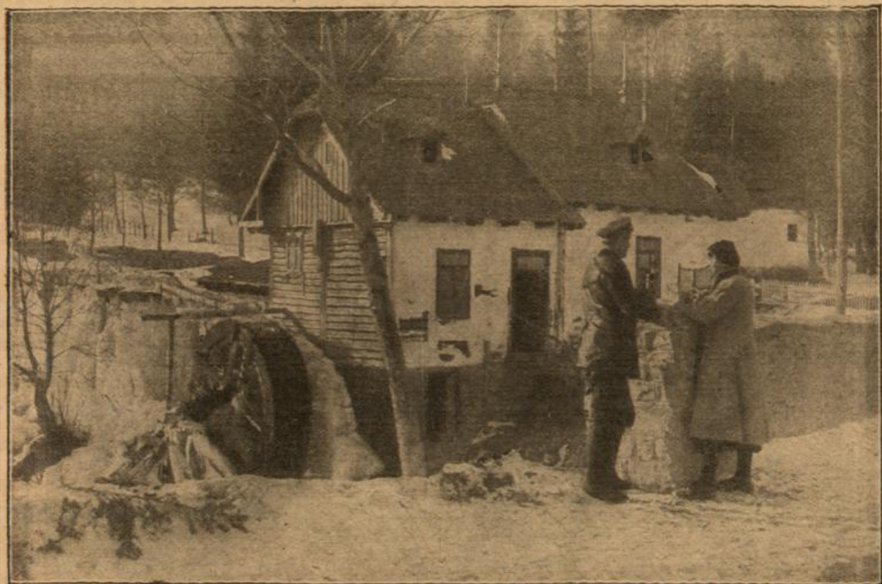
In den verschneiten Karpathen. Wassermühle auf der ins Petroleumgebiet führenden Paß-Straße.
