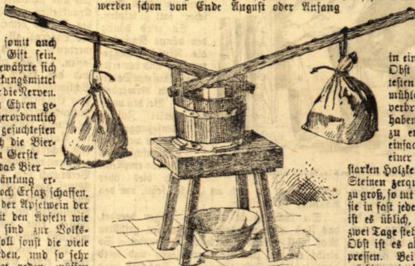
Abbildung 1. Einfache Obstpresse nach Hülbrock-Buttbus. In den Enden sind Steine, welche den Druck, verstärkt durch Hebelkraft, ausüben. Die Hebel drücken an der Stelle ihrer Kreuzung auf einen Auslasspfloß, welcher auf den Press- beutel aufgeschraubt ist. Der Saft läuft durch den festartig durchlöchernten Boden des Holzgefäßes und den unten offenen Schüssel in das untenstehende Gefäß.
