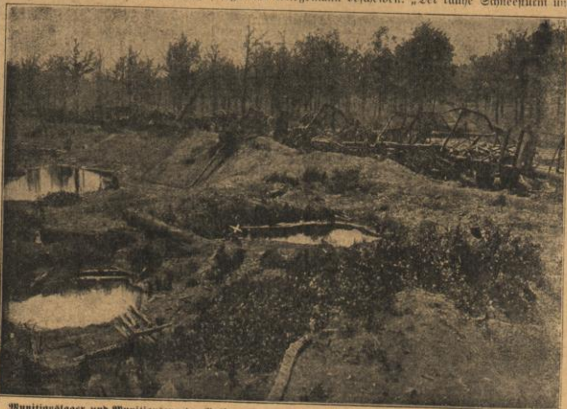
Munitionslager und Munitionszug der Russen, die von deutschen Fliegern und Artillerie vernichtet wurden. An Stelle der mit Wasser gefüllten Zwerndrucker befanden sich vorher Munitionslager. — Phot. Rich. Spelling.
