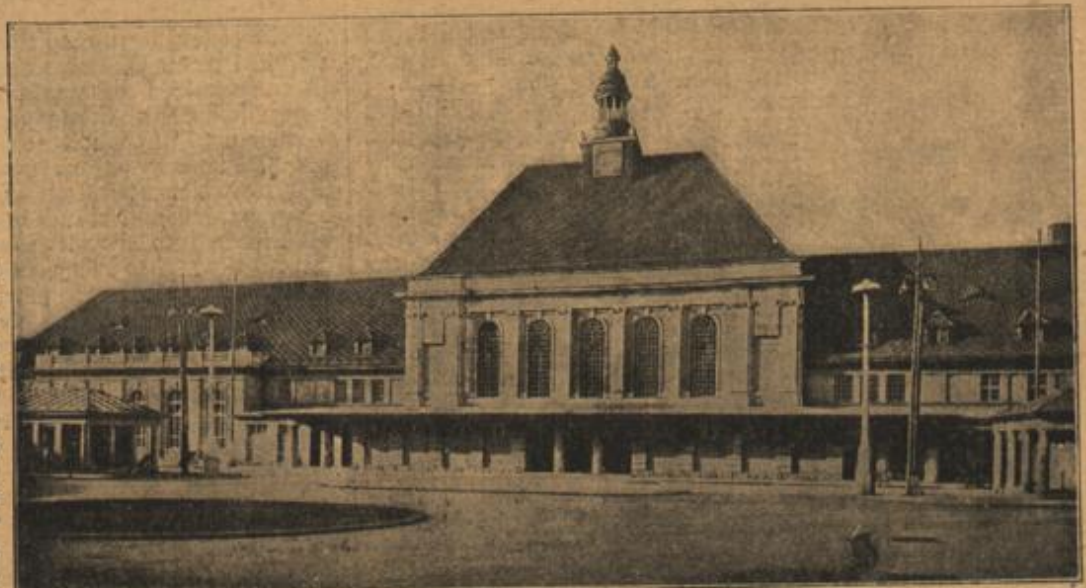
Der soeben fertiggestellte neue Bahnhof in Görlitz.
