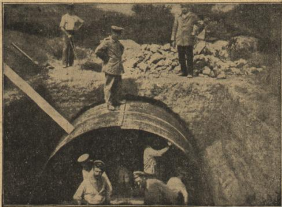
Bau eines bombensicheren Unterstandes in Mazedonien.
