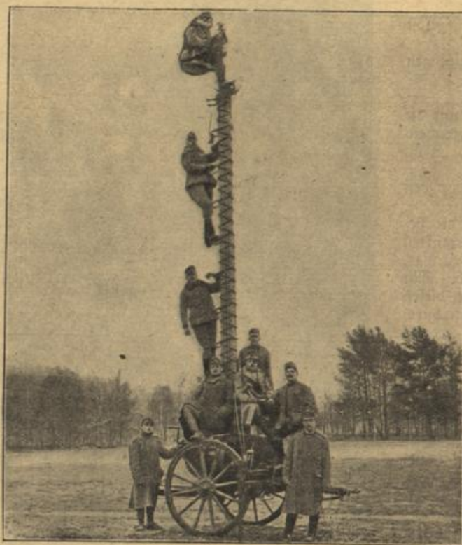
Fahrbare und zusammenlegbare österreichisch-ungarische Beobachtungsstelle mit Telephon.
