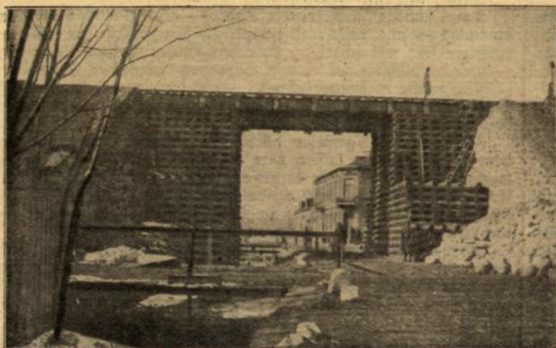
Notbrückenbau aus Bahnschwellen.
