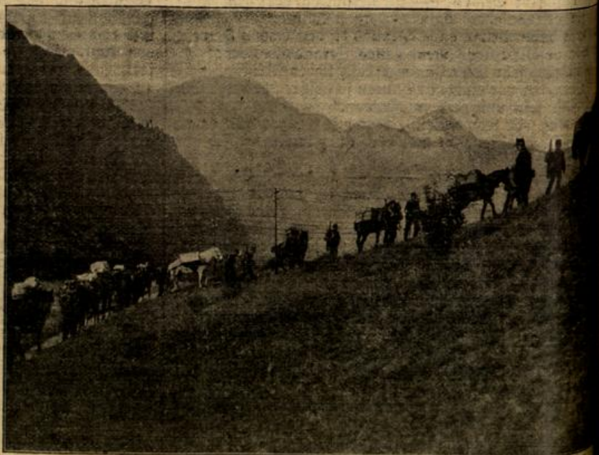
Schweizerische Bundestruppen: Munitionszufuhr für die Befestigungsanlagen an der italienischen Grenze.
