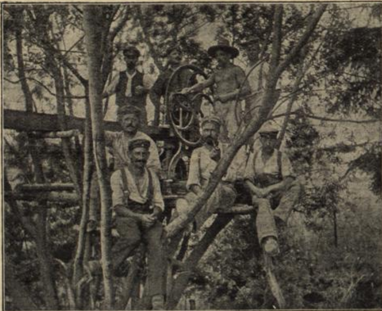
Pumpvorrichtung zum Entwässern und Trockenhalten von Schützengraben.
