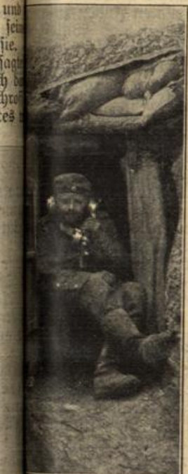
alle im bombensicheren Unterstand.
