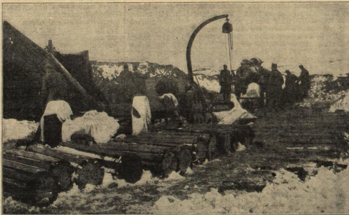
Vom Kriegsschauplatz in Ostgalizien: Österr.-ungar. 30,5 cm-Mörser mit Hebelkran für fast mannshohe Granaten. Im Vordergrund Munitionsvorrat. Die weißen Tücher dienen zur Bedeckung gegen Ziegersicht. Phot. Klopshot, Wien.
