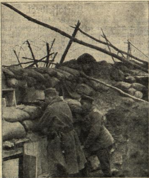
Sicherung der Schützengräben durch Drahtnetz vor Handgranaten.
