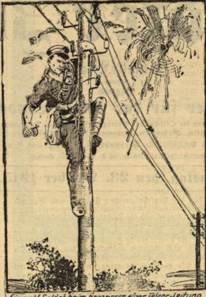
Ein engl. Soldat beim Reparieren einer Telegraph-Leitung.
