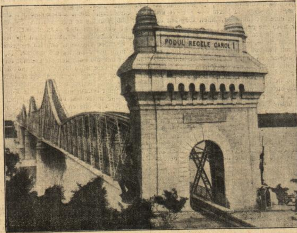
Die 750 Meter lange Donau-Brücke bei Cernavoda.
