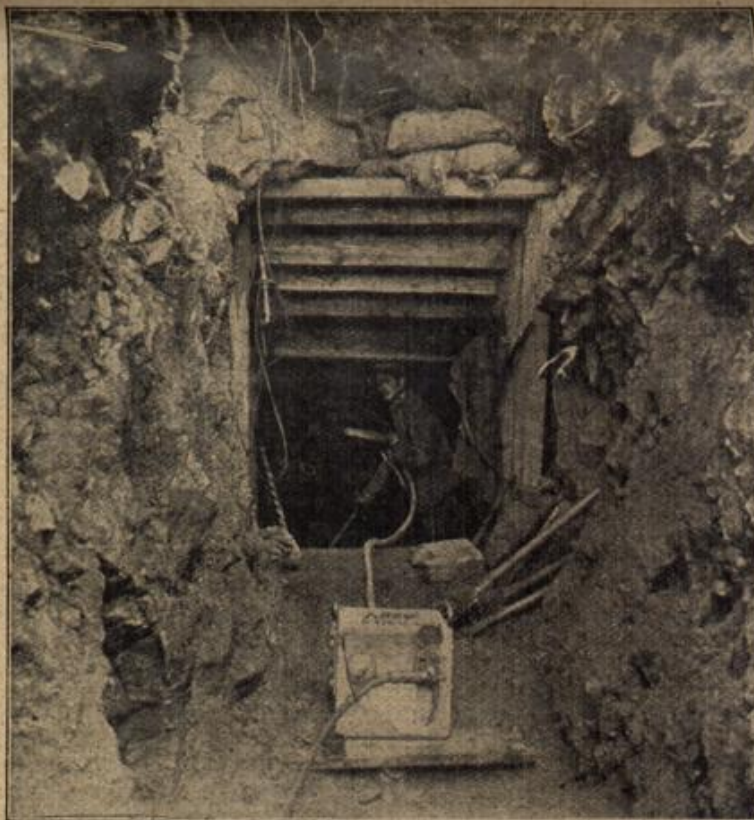
Von den Minenkämpfen in den Vogesen: Elektrischer Gesteinsbohrer in einem Felsen. Phot. Wipperling. (Geniert Generalstab.)
