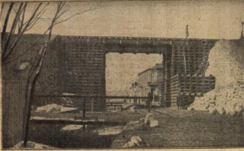
Notbrückenbau aus Bahnschwellen.
