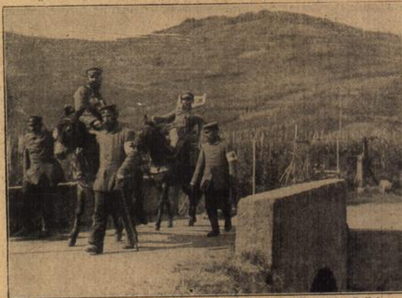
Verwundetentransport in den Vogesen. Hospit. Eberth, Kassel.
