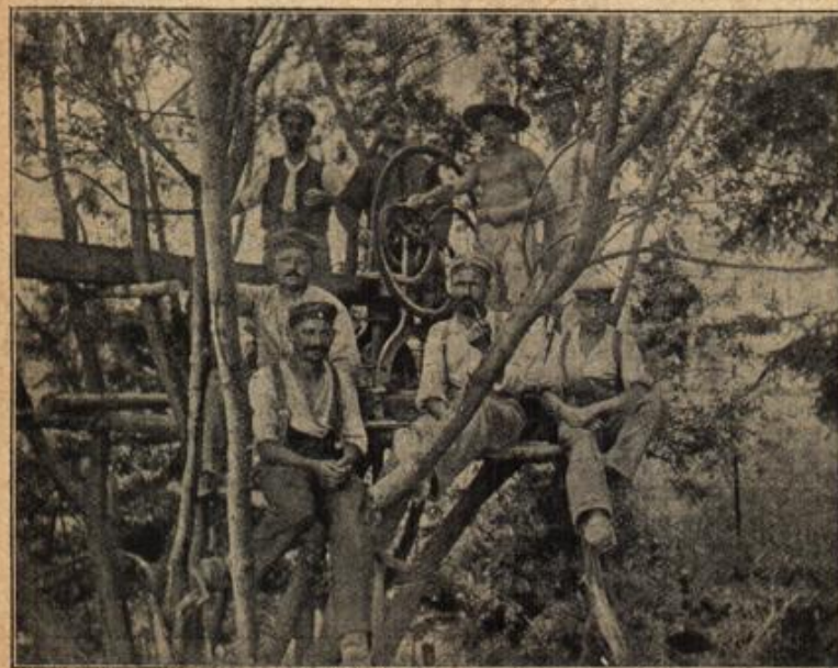
Pumpvorrichtung zum Entwässern und Trockenhalten von Schützengräben.
